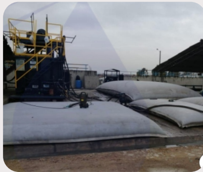
Proceso de llenado de los Geocontenedores
