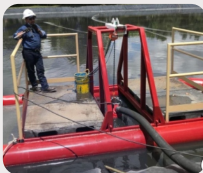
Dragado de Lodos (Piscina de Oxidación)
